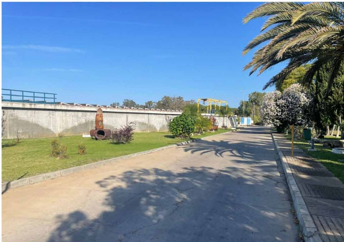
La EDAR de Las Galeras en El Puerto J.Z
