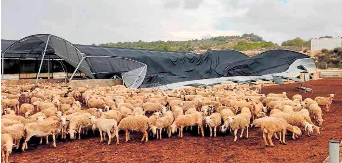
Cubiertas de los corrales destrozadas por la lluvia y el granizo en Ojós. lv
